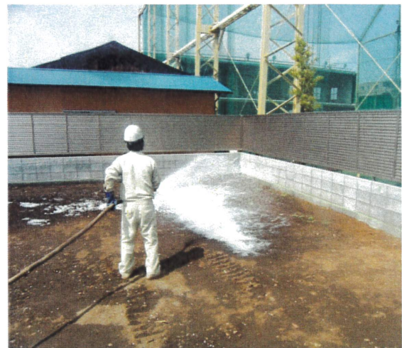
散布作業中(宅地造成地の人力散布)
