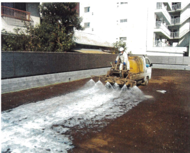
散布作業中(宅地造成地の機械散布)
